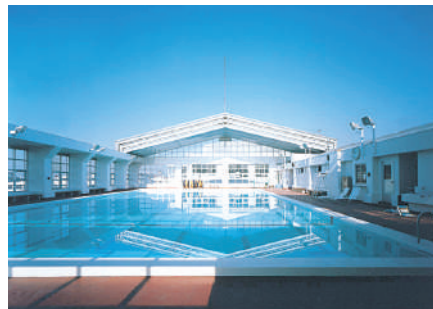
屋根開閉型プール
