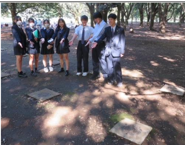
マンホールトイレ用のマンホール
