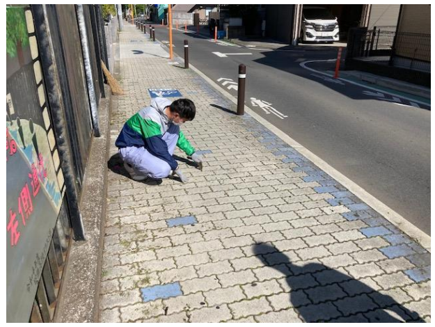
インターロッキングの目地を一つ一つ丁寧に。
