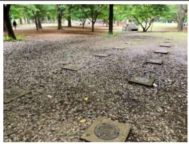
マンホールトイレ用の穴です。
