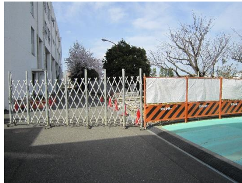
(校舎東側) 緊急時は道路側と校庭側に抜けられます。
