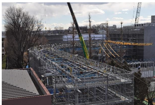
(建設中の上空通路上部)
