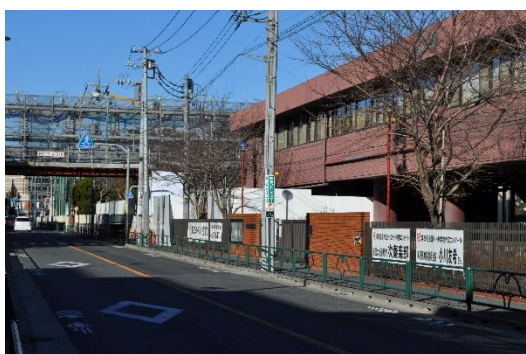
(建設中の上空通路)
