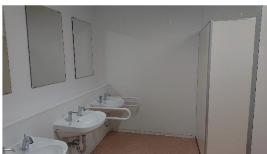
(改修後のトイレ)
