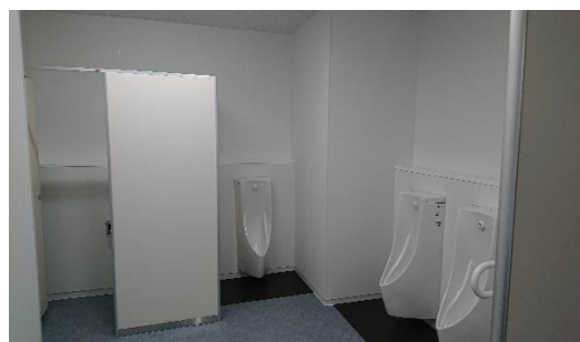
(改修後のトイレ)
