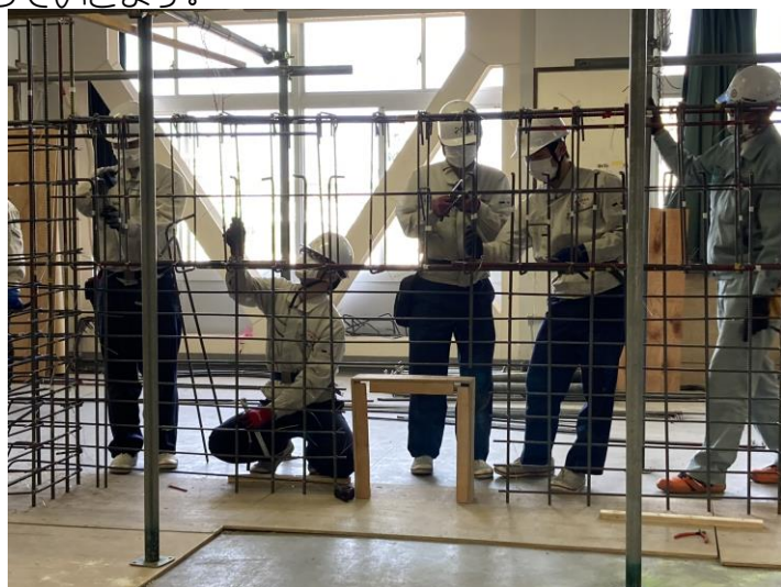
← 円形バルコニーの手すり部分の鉄筋の組立
