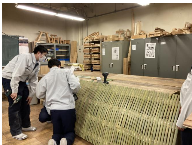
竹を植木はさみで割って、厚さを少し薄くして、表面に取り付けていきました。
