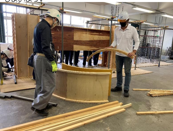
↑曲面型枠の材料を仮置き
