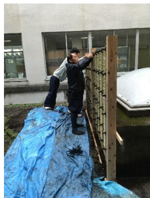
シュロ縄を、男結びで結びます。先生のようにきっちりと締めるのは難しい。
