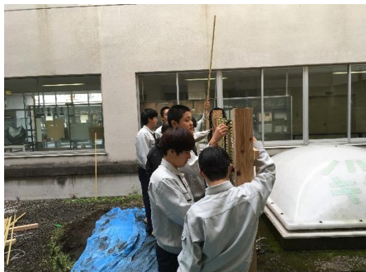
シュロ縄を、男結びで結びます。先生のようにきっちりと締めるのは難しい。
