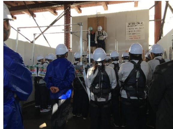
作業台の点検
