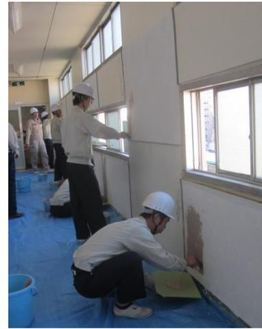
仕上げには、ハケ引き・くし引き・スポンジ等を用いたり、コテでランダムに仕上げたりします。
