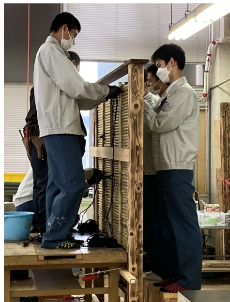
室内で組立できるところは室内で行い外に設置しました。
