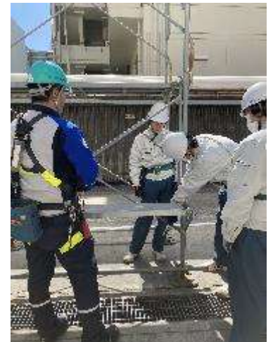
↑ブラケット足場の取り付け方と注意点について学びました。
