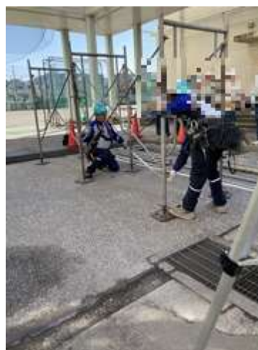
↑枠組足場を整然と設置するための方法を学びました。
