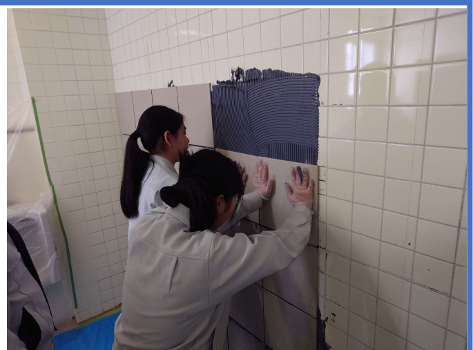
↑接着剤を塗って、タイルを貼り付けました。 目地の間隔が同じで、真っ直ぐになるようにするのは大変でした。
