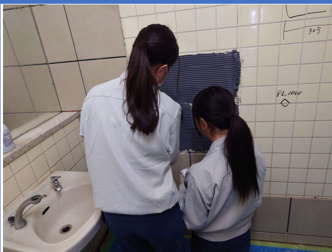
↑接着剤を塗って、タイルを貼り付けました。 目地の間隔が同じで、真っ直ぐになるようにするのは大変でした。
