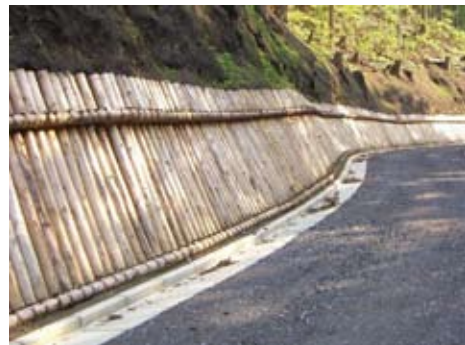
林道の丸太法面保護工（奥多摩町）
