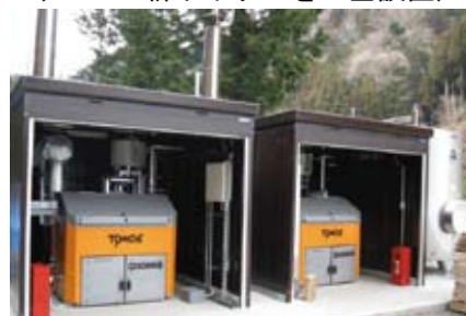
〈80kW の薪ボイラーを 2 基設置〉
