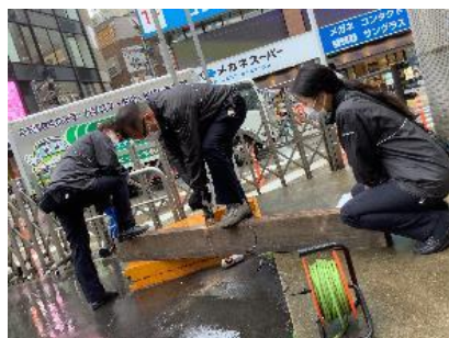
▲マクラギを切断処理
