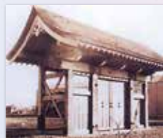
昭和25年 現在地に落成した正門
