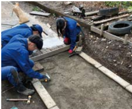
総合実習：園路施工
