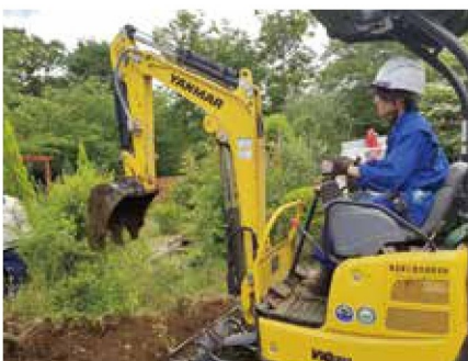
総合実習 重機操作
