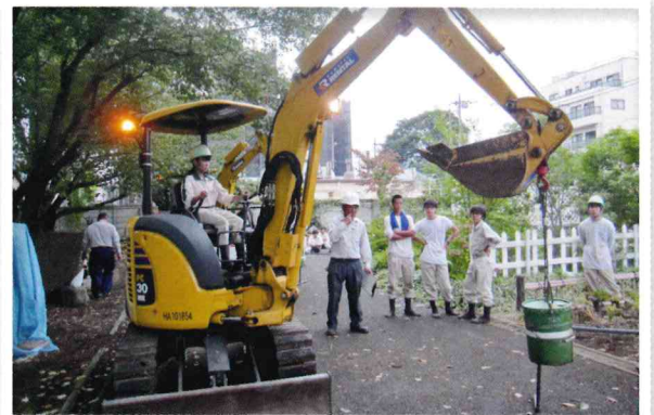
重機車両講習
