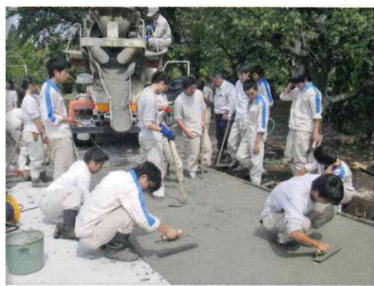
コンクリート打ち
