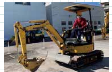
▲小型車両系建設機械
