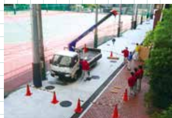
▲移動式クレーン運転・玉掛け特別講習
