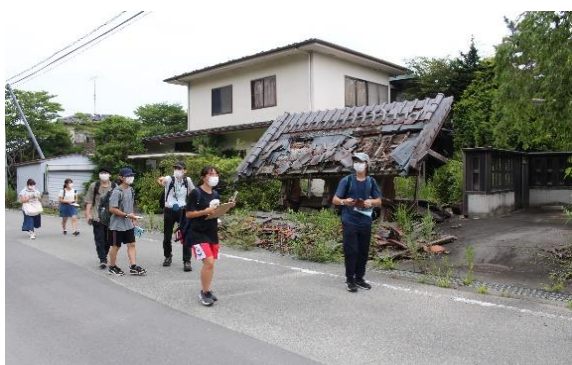
双葉市街のお寺の崩れた山門
