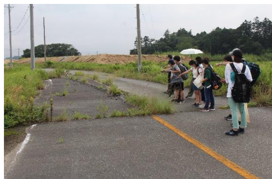
地震でずれた道路
