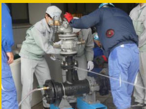
《大成機工株式会社》 水道管の漏水補修工事を体験
