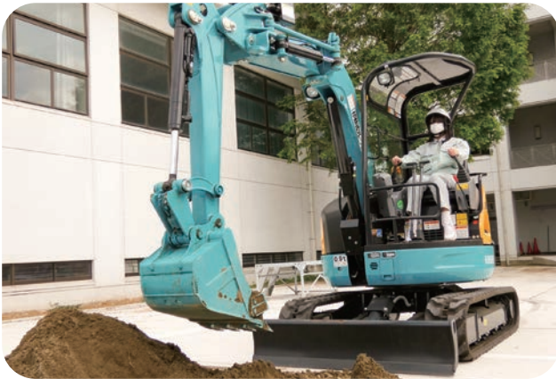
パワーショベルの操作
