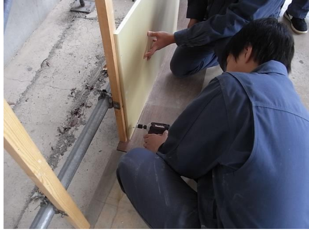
石膏ボード取り付け
