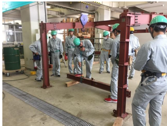
吊りこみ用のスリングベルト準備
