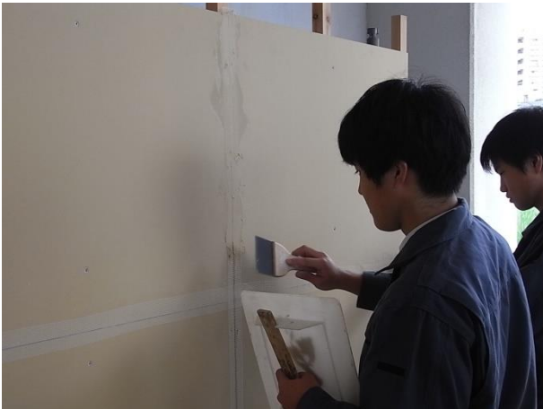
ジョイントテープ・パテ処理
