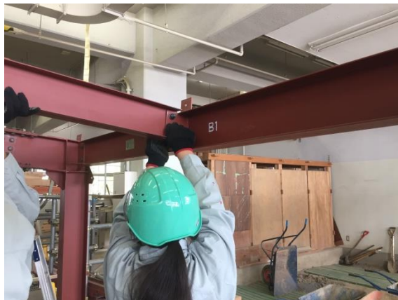
小梁の取り付け（ボルト締め）
