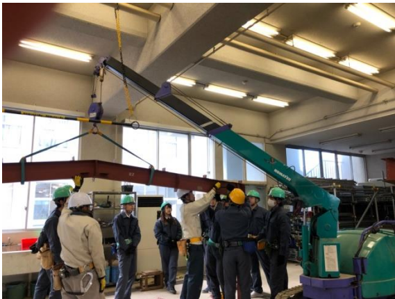
大梁①をクレーンで取り付け
