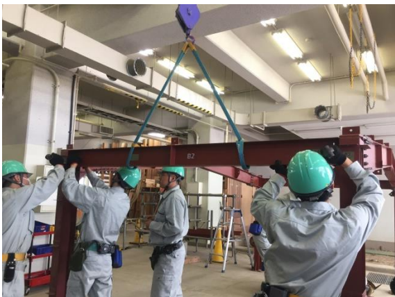
大梁②をクレーンで取り付け
