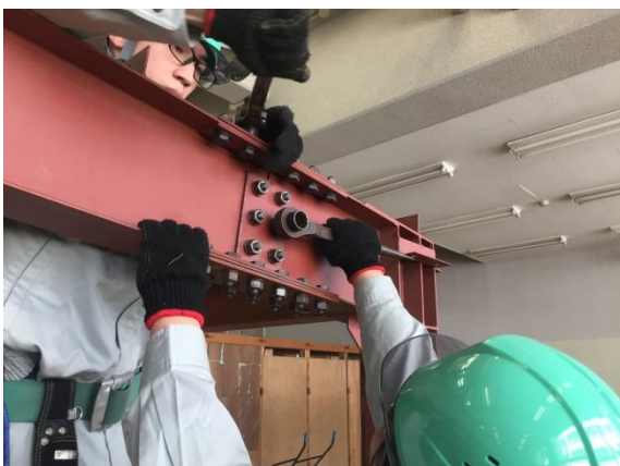
大梁ボルト締め
