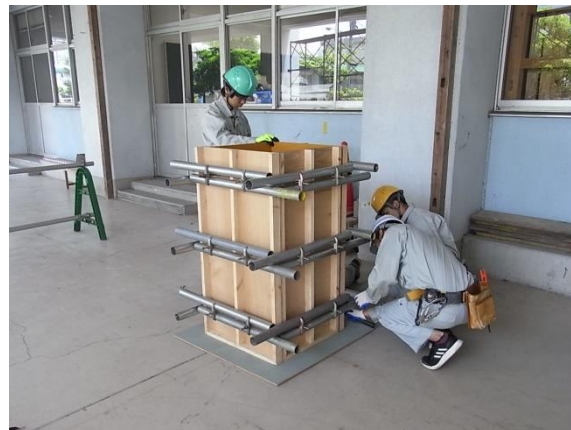
単管取り付け
