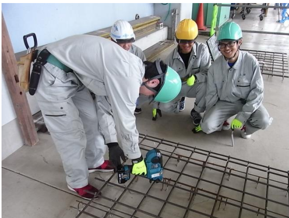
自動結束機による配筋
