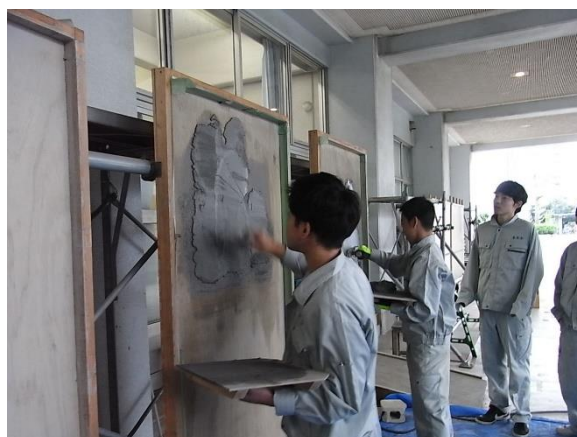
壁モルタル塗り②
