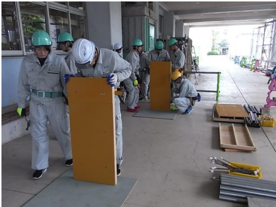
小面の型枠建込
