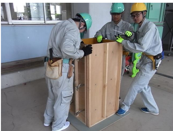
大面の型枠建込
