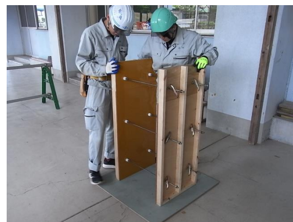
小面の返し型枠建込
