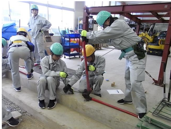
せん断補強筋の加工
