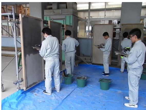
壁モルタル塗り①
