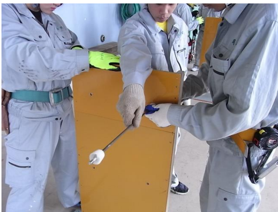
セパレーター取り付け
