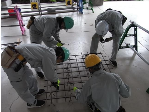
基礎の配筋（ハッカー使用）
