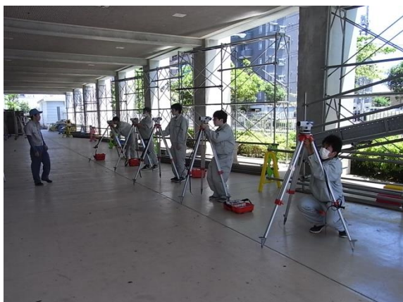
自動レベル据え付け
