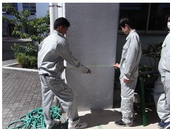
高さ1mの測設
