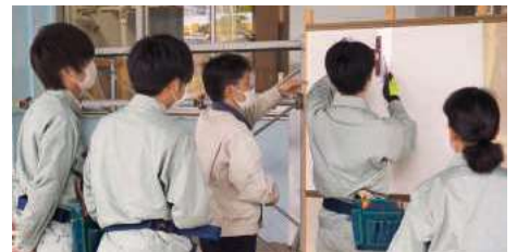
インテリア工事
