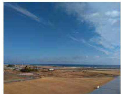
嵩上げし整地された土地
