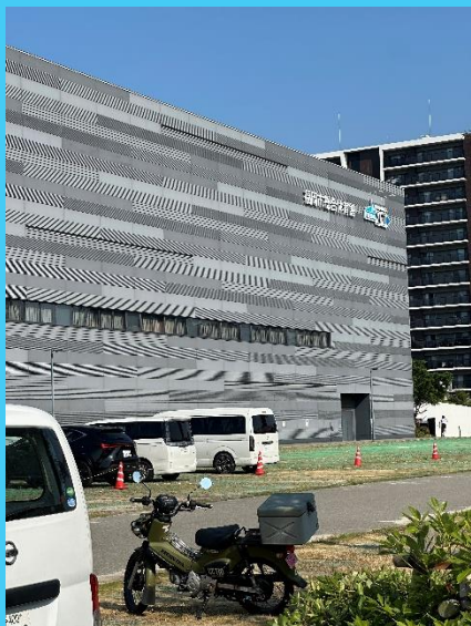
福岡総合体育館(照葉積水アリーナ)
