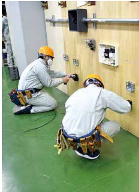
大規模電気工事
