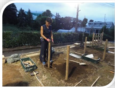
間柱を据える
