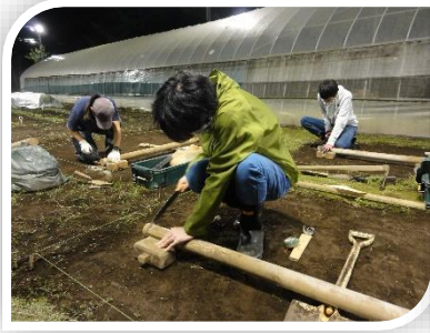
丸太の天端を切る
