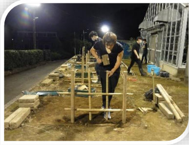
立子の据え付け
