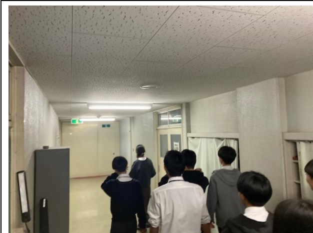
閉まっている防火扉に向かいます。
