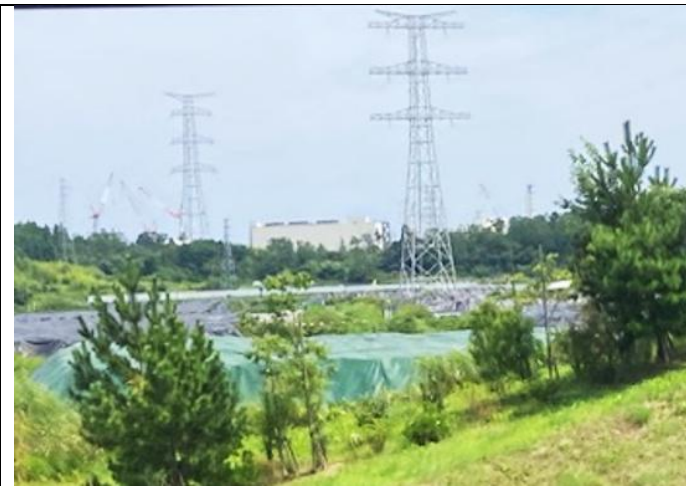
バス車内から原子力発電所を望む 手前は、中間貯蔵施設
