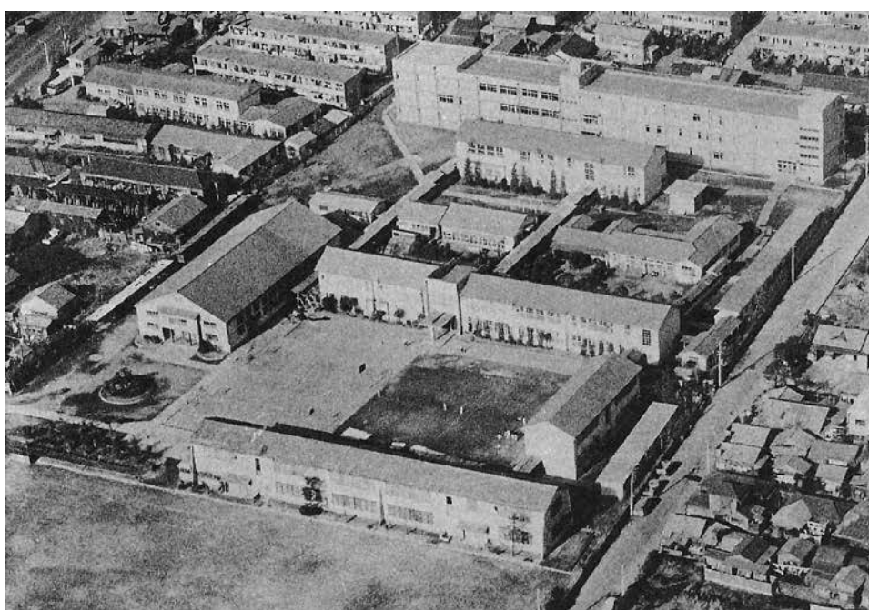
昭和38年 当時の校舎（第一校舎取り壊し直前）
