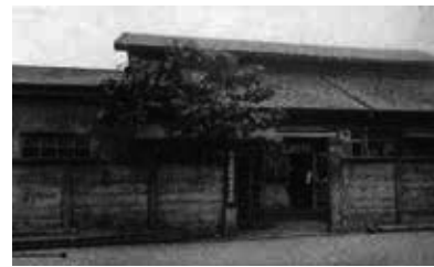
昭和29年頃の公共職業安定所 (千住橋戸町47) (足立写真名鑑1954より)
