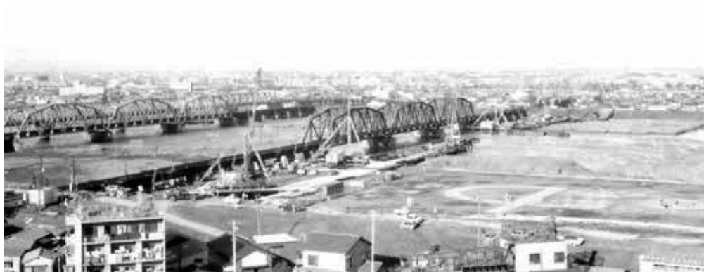
昭和 44 年 北千住・荒川橋梁
